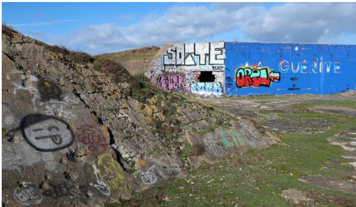
Vue du bunker - cuve nord pour canon de 34 cm avec magasins de munitions
