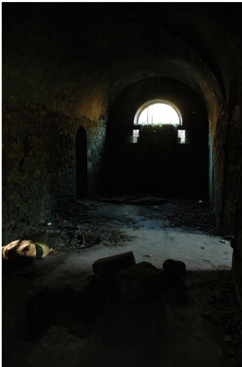
Vue intérieure : baie haute dotée de barreaux et encadrée par deux créneaux de fusillade (état en 2006)
