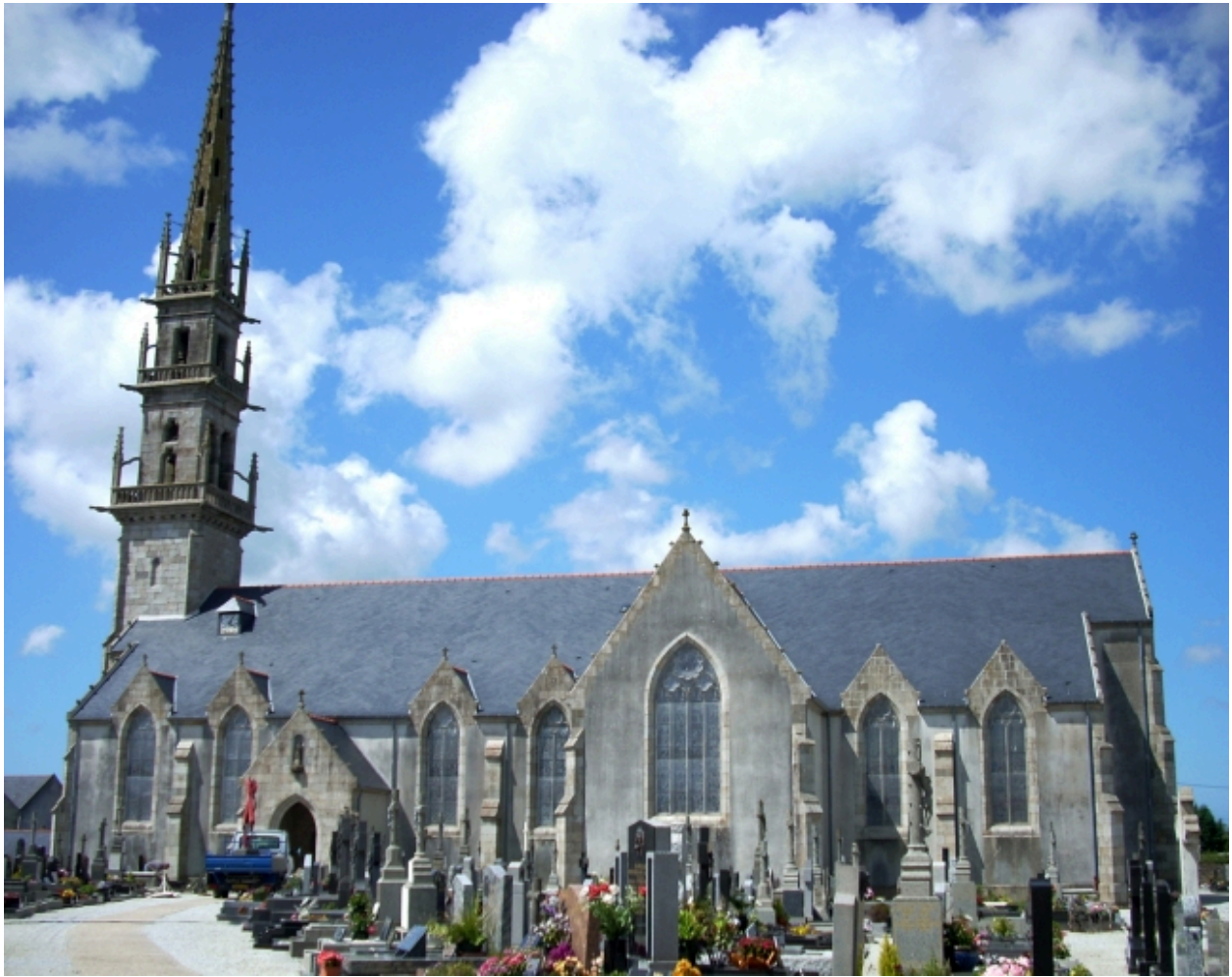
Ploudaniel, église Saint-Yves : vue générale sud
