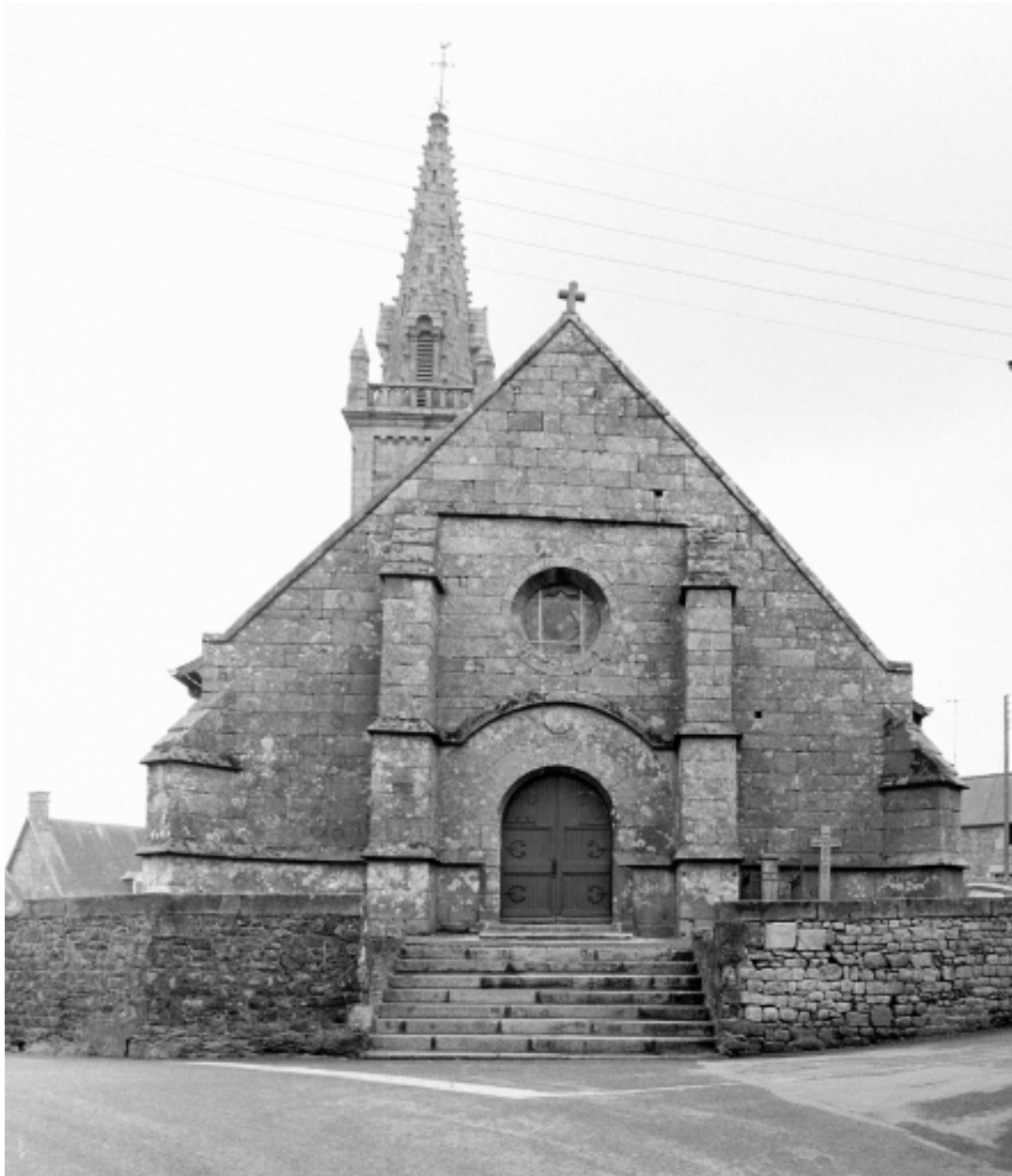
Elévation Ouest : vue générale
