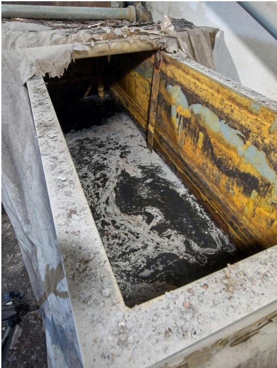
Vue de l'un des deux bacs en résine polyester. Le liquide provient de l'infiltration des eaux pluviales depuis les joints de la dalle de couverture
