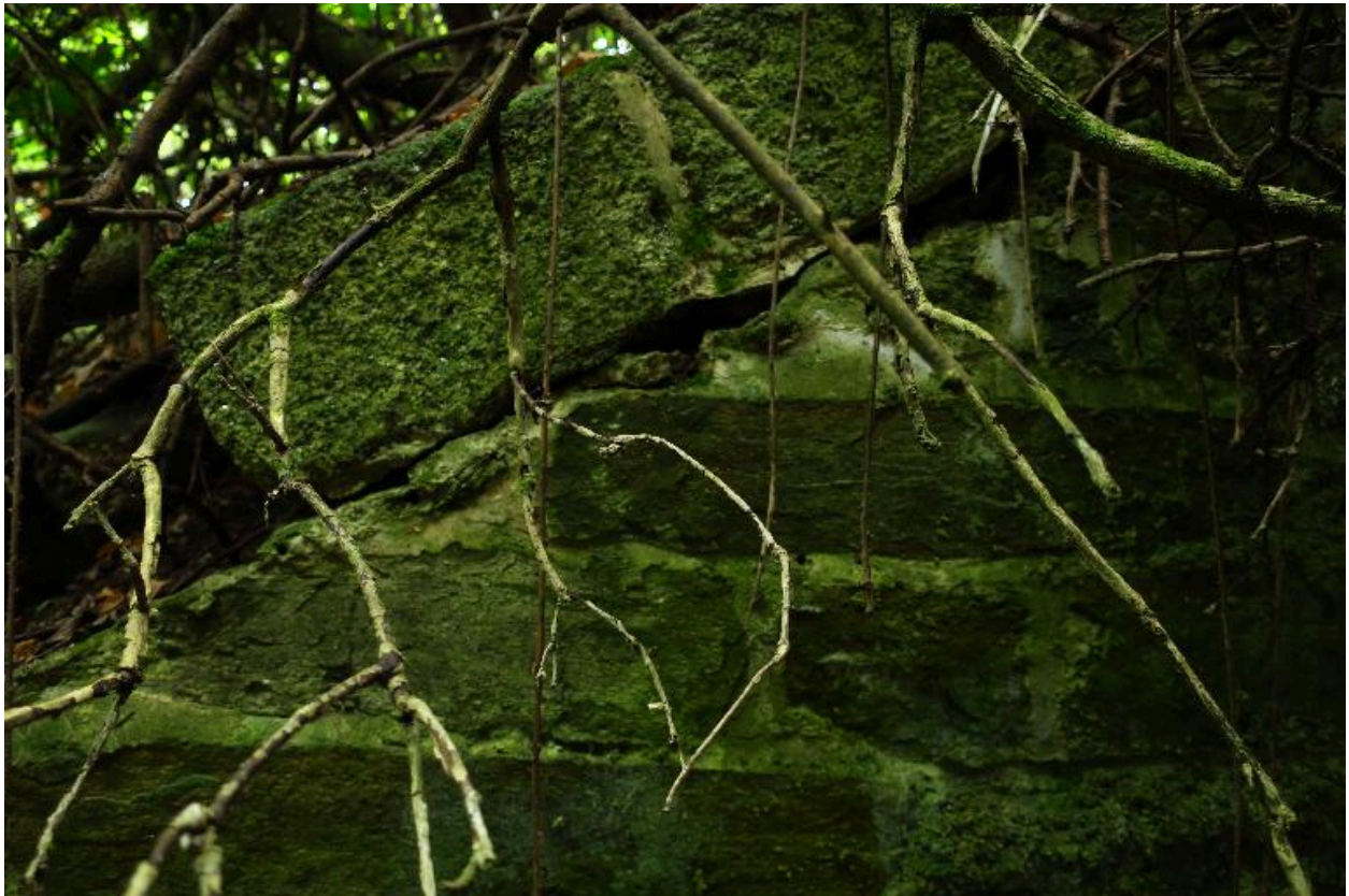
Groix, fort dit Fort Surville, batterie basse, détail de la façade de la traverse.
