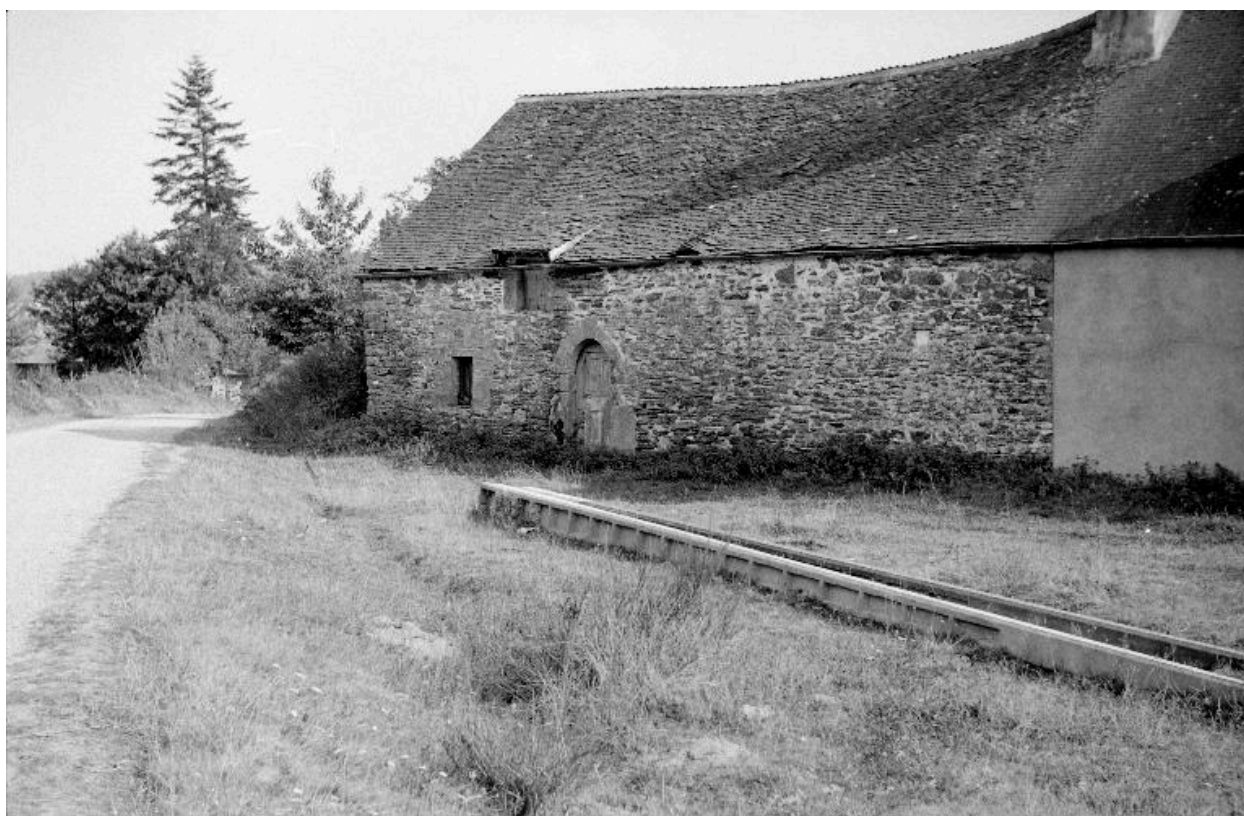
Ferme 31 (état en 1969)
