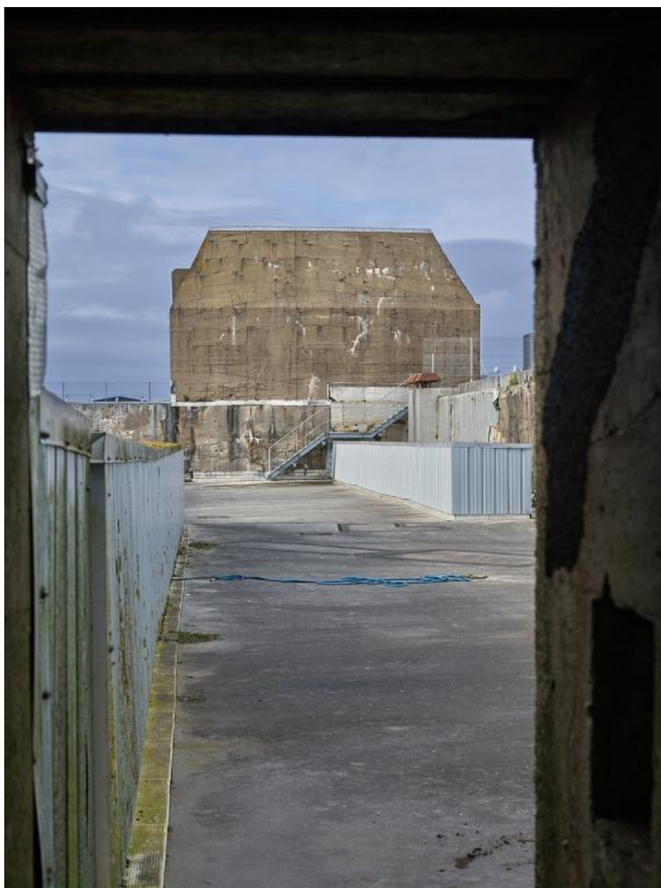
Vue générale depuis le bunker - cuves sud
