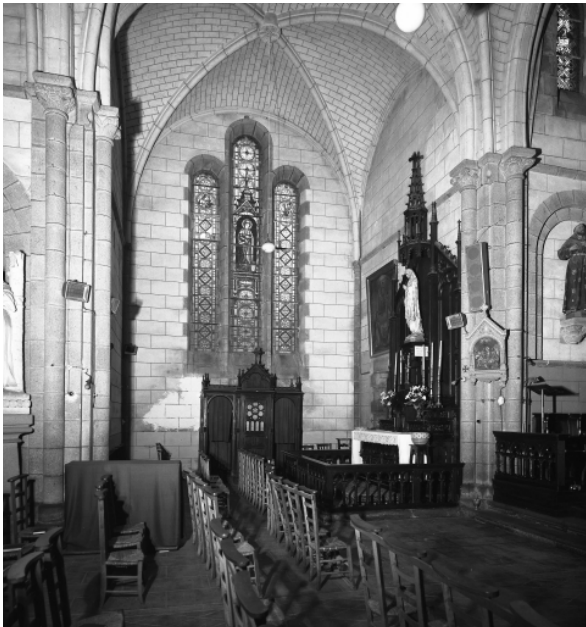
Saint-Ségal, église paroissiale Saint-Séverin : intérieur, bras de transept sud, état en 1972
