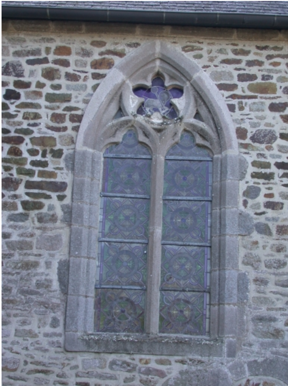
Nef, mur nord, (baie 9)
