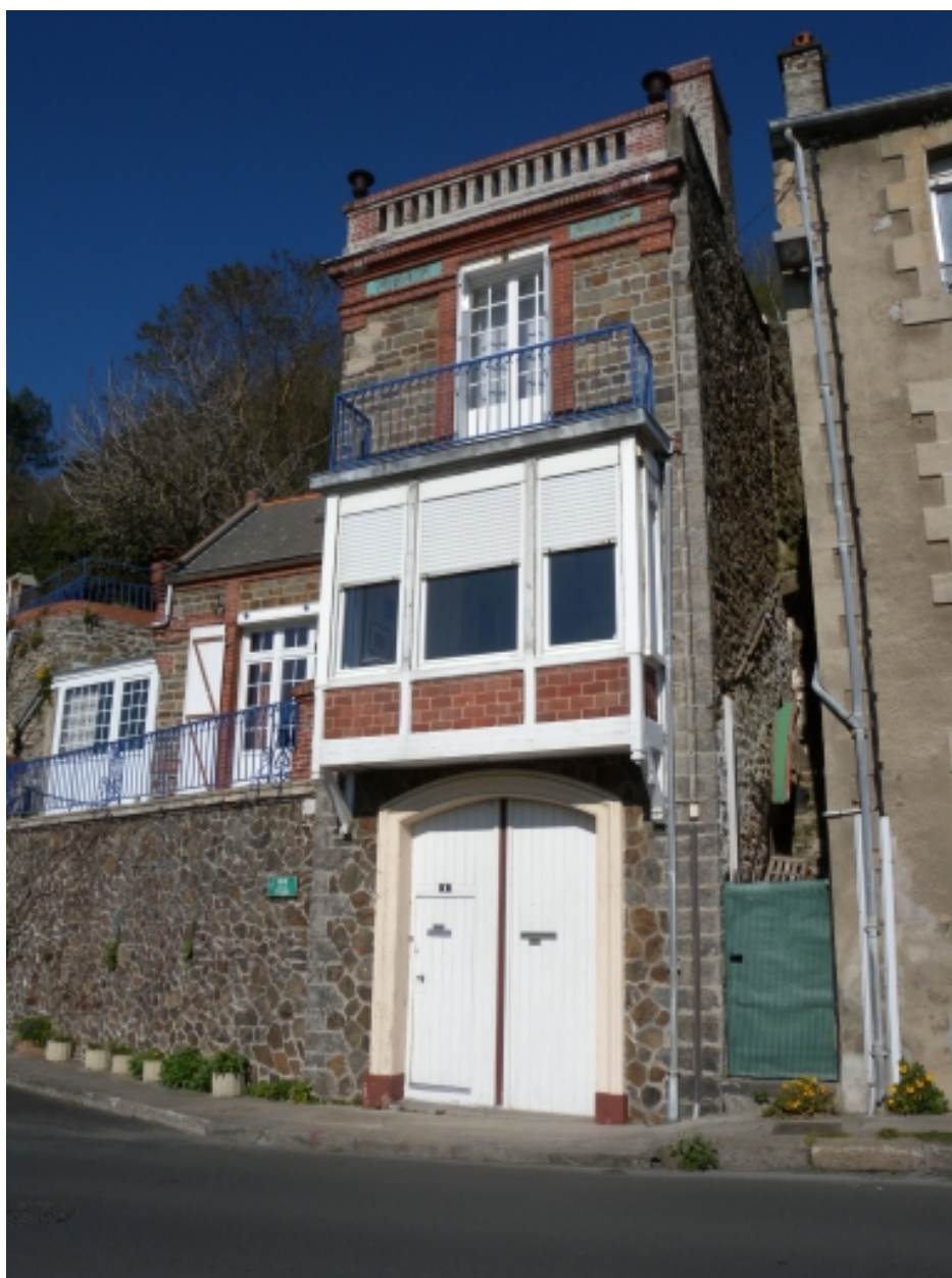
Vue d'un bâti littoral résidentiel à 2 étages avec terrasse
