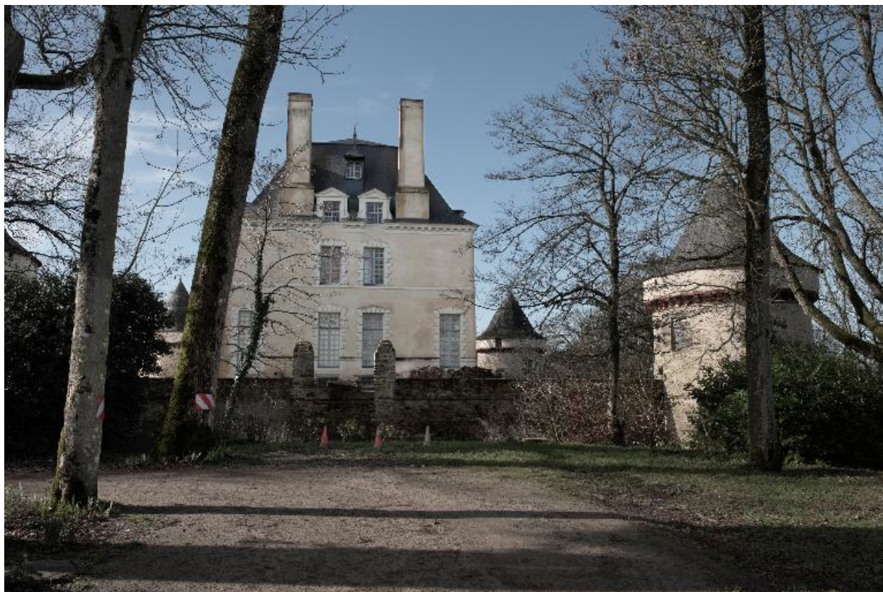
Vue de la façade est du château
