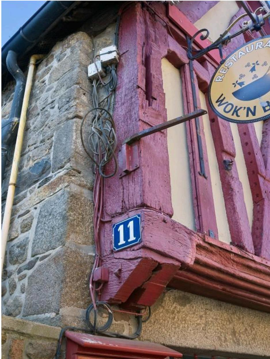
Le poteau cornier conserve la trace d'une mortaise et d'arrachement suggérant une ancienne console et un décor bûché.
