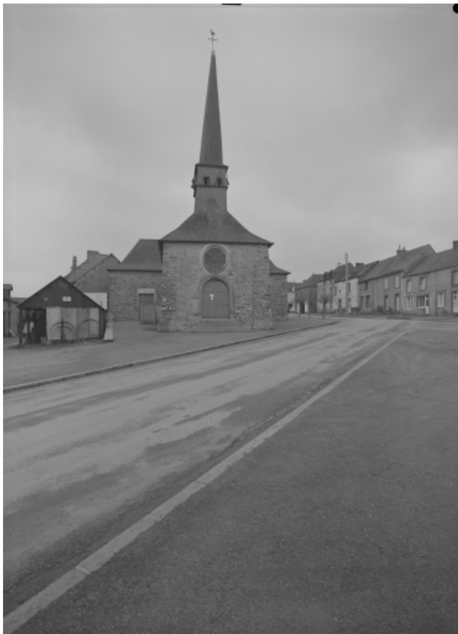
Elévation ouest : vue générale
