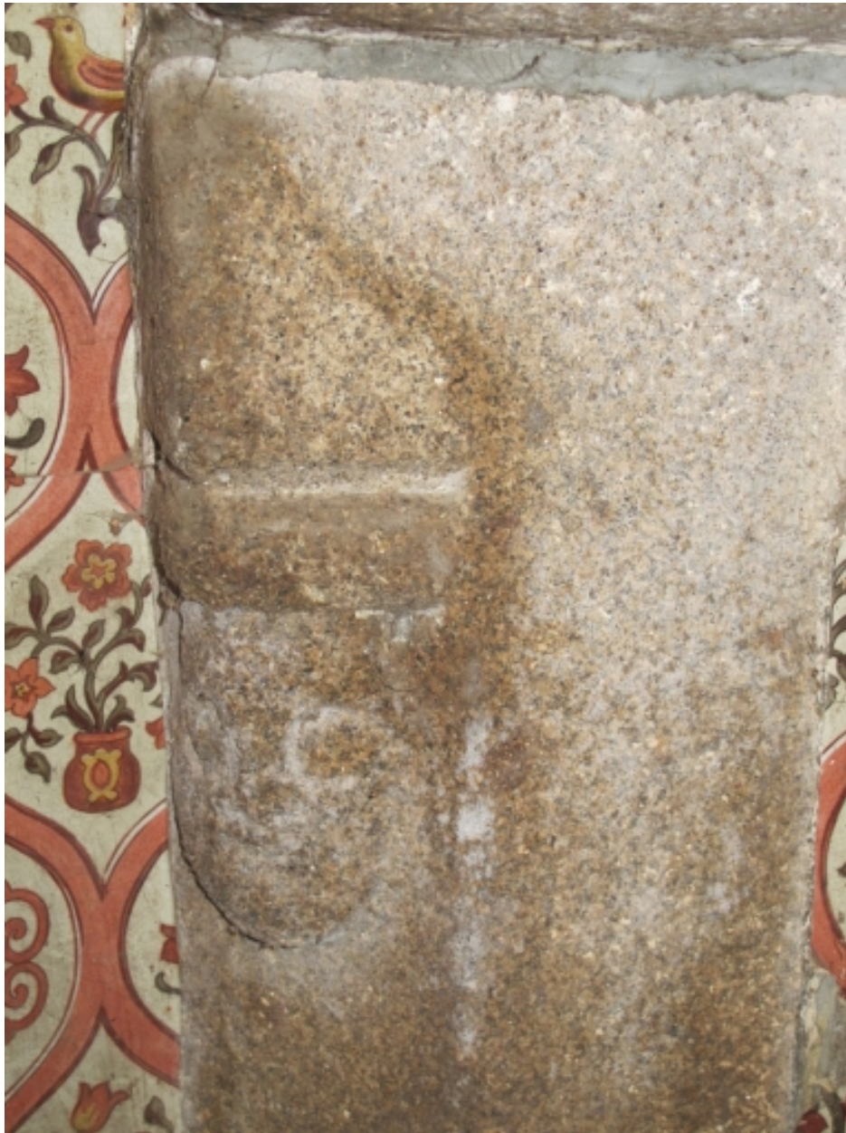
Détail du piédroit de la cheminée
