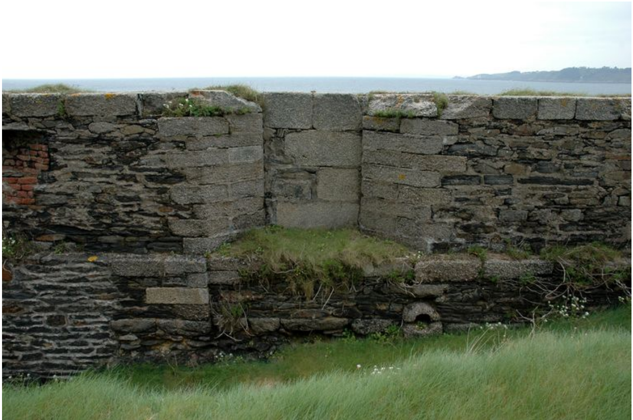
Vue de la batterie de Cornouaille : embrasure comblée pour permettre le tir à barbette (c'est à dire au dessus du parapet)
