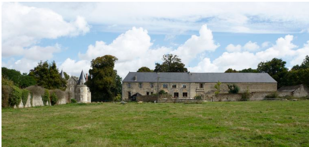
Château, dépendance ouest : élévation ouest (état en 2010)
