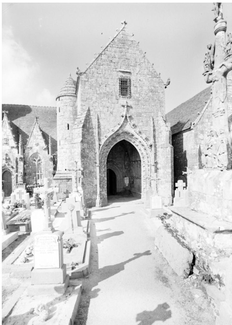
Façade sud : vue du porche
