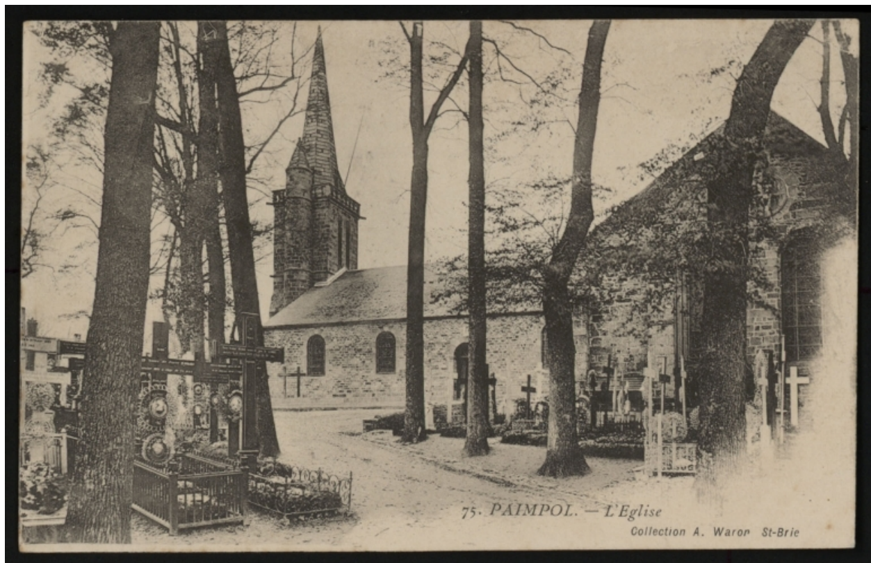
Vue générale avant destruction, 1er quart du 20ème siècle (AD 22)
