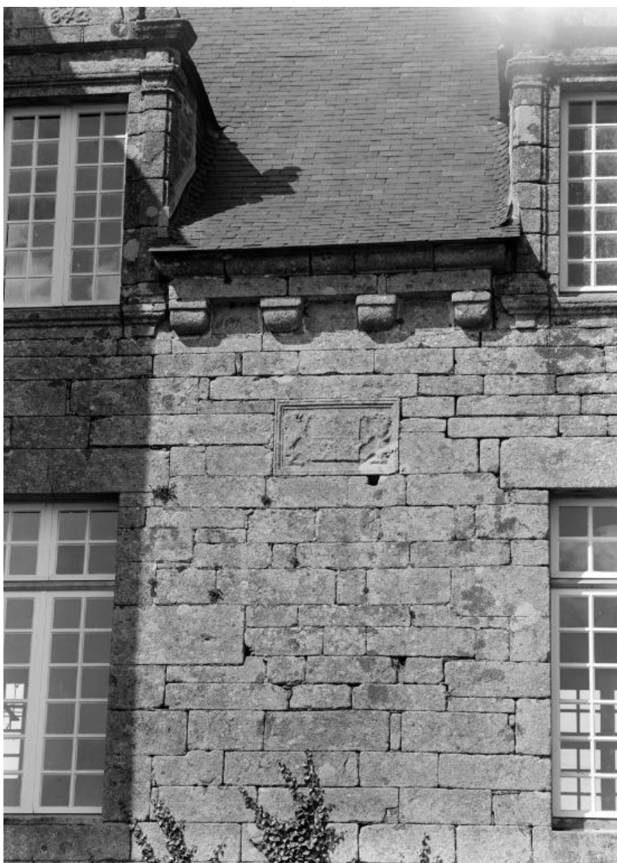
Façade sud partie centrale, détails appareillage de la corniche et panneau sculpté
