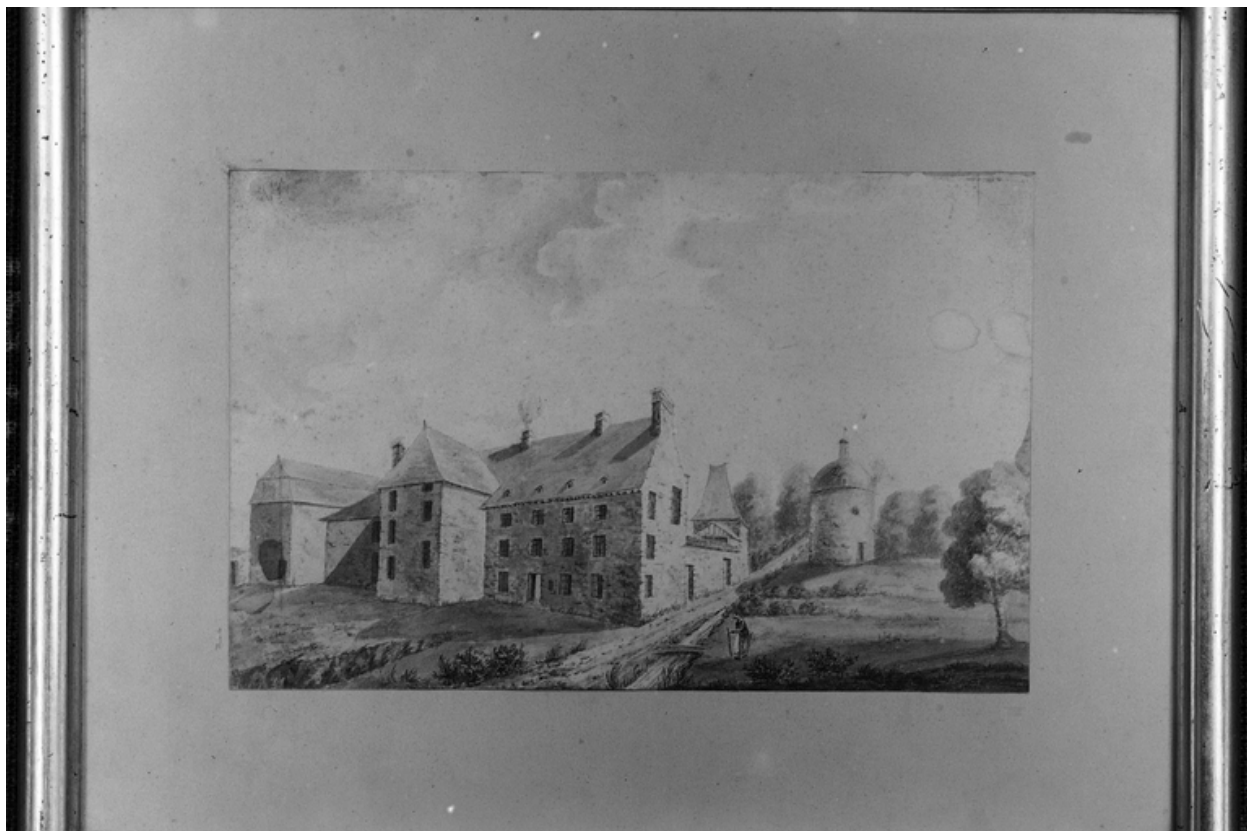
Vue générale, nord-ouest.
