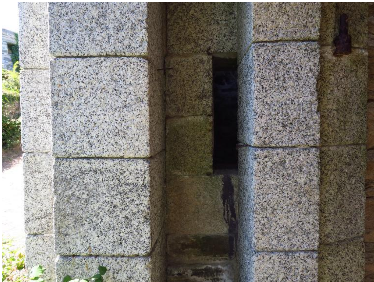
Groix, batterie du Bas-Grognon, corps de garde crénelé, créneau de défense de la porte.
