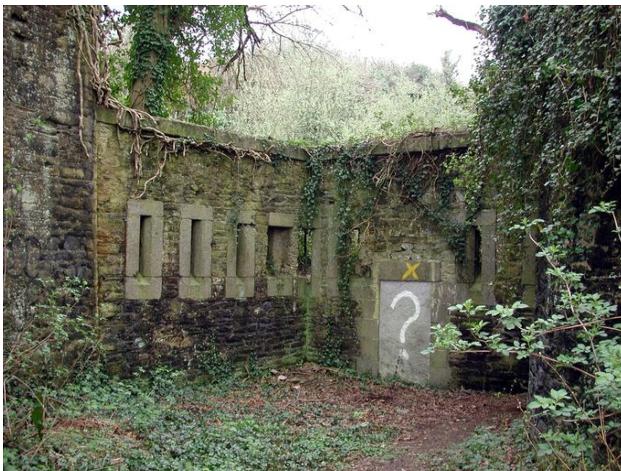
Vue de l'enceinte du fort de mer. Elle est percée de créneaux de fusillade
