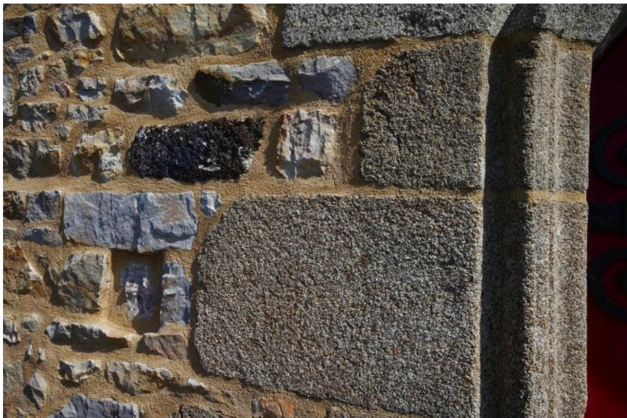
Détail de la maçonnerie
