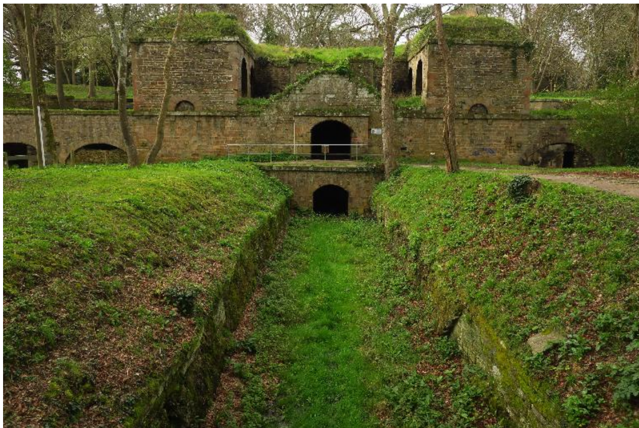
Le Palais, enceinte urbaine, réduit G, vue de la gorge dans l'axe de la caponnière.
