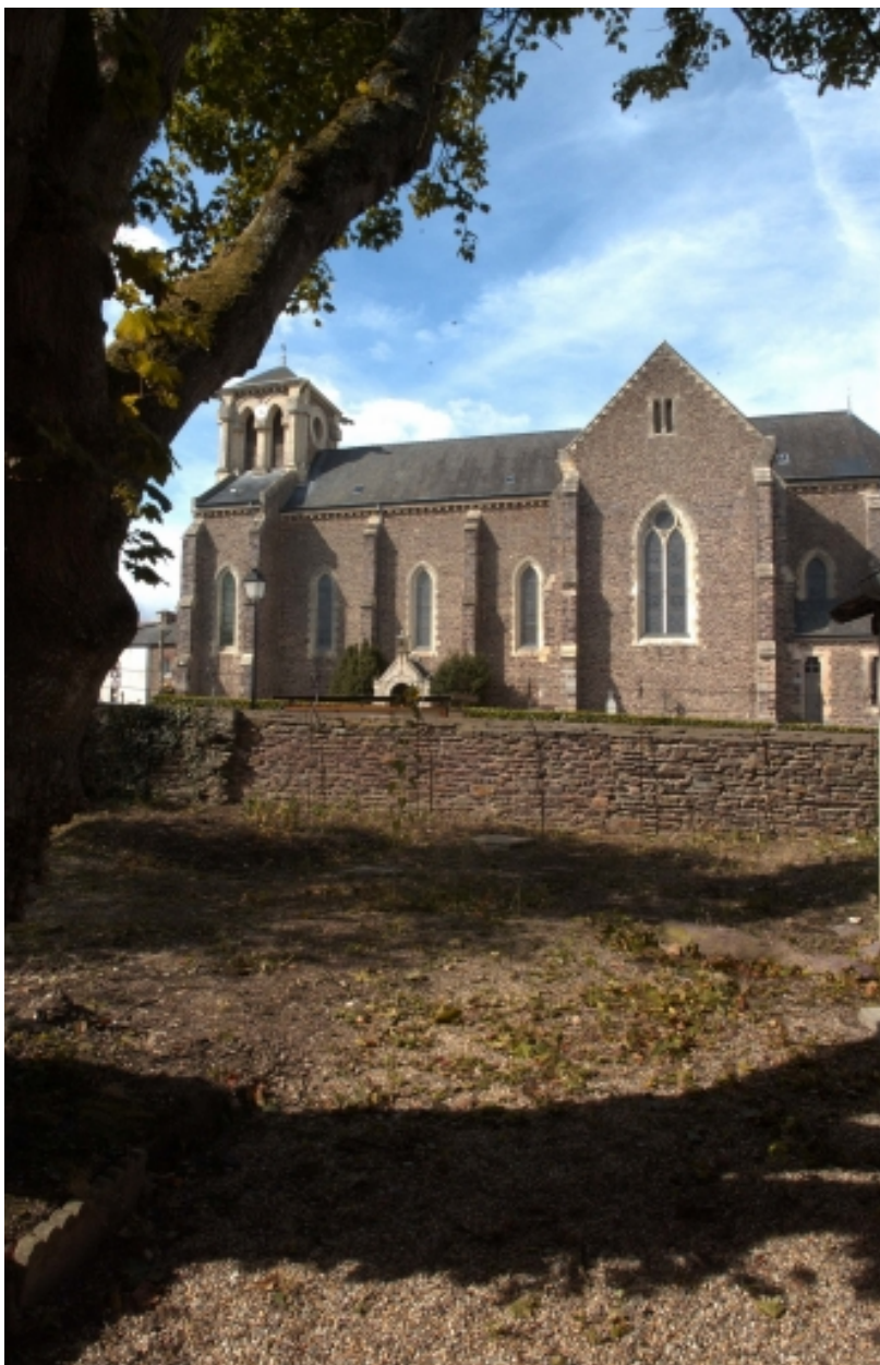
Vue de situation sud-est
