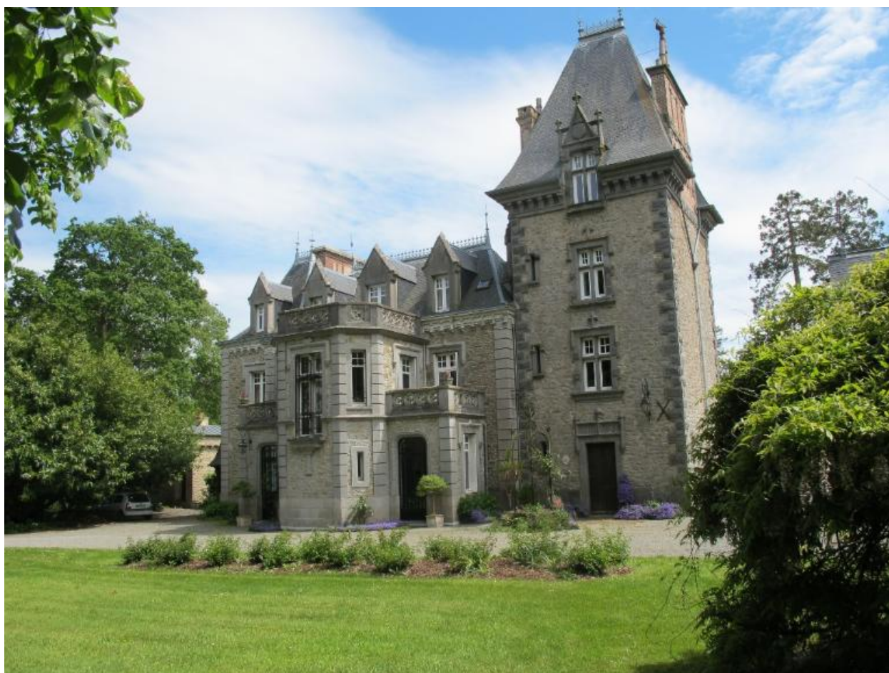
Facade antérieure, prise de trois quart
