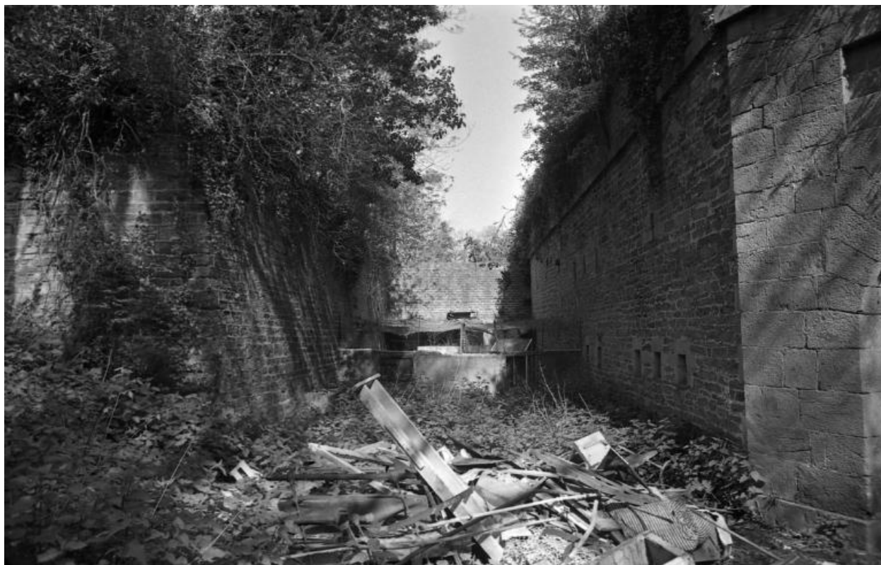
Enceinte de ville - Réduit B, élévation postérieure
