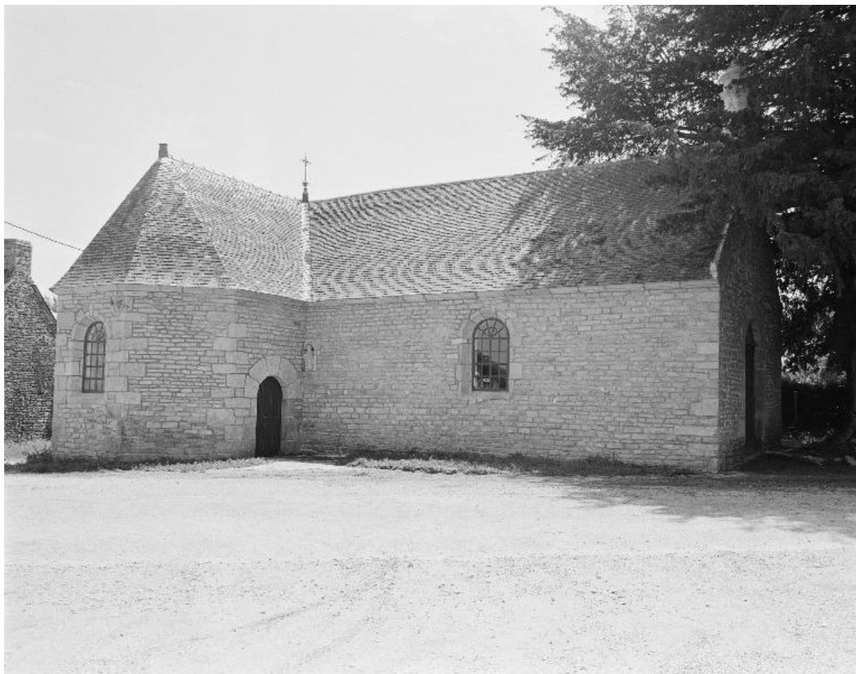
Elévation nord (état en 1991)
