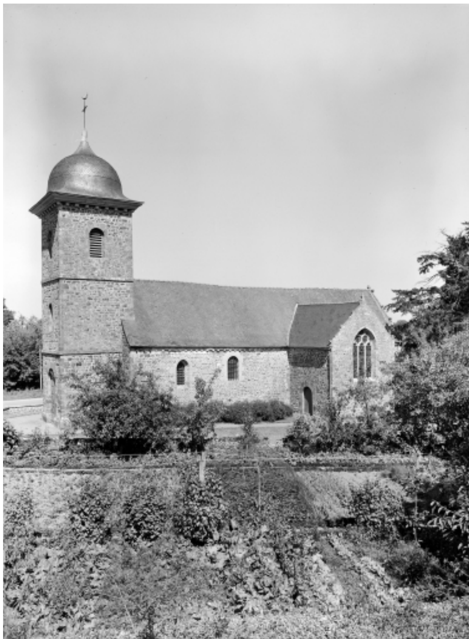
Elévation Sud : vue générale
