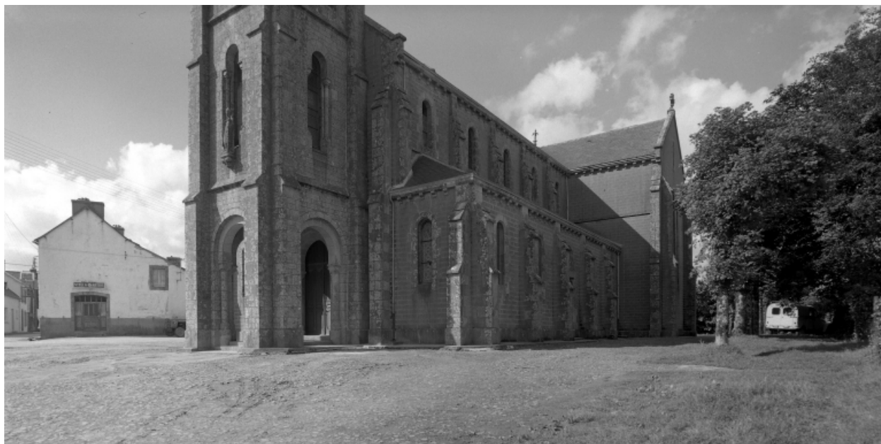
Saint-Ségal, église paroissiale Saint-Séverin : vue générale sud-ouest, état en 1972
