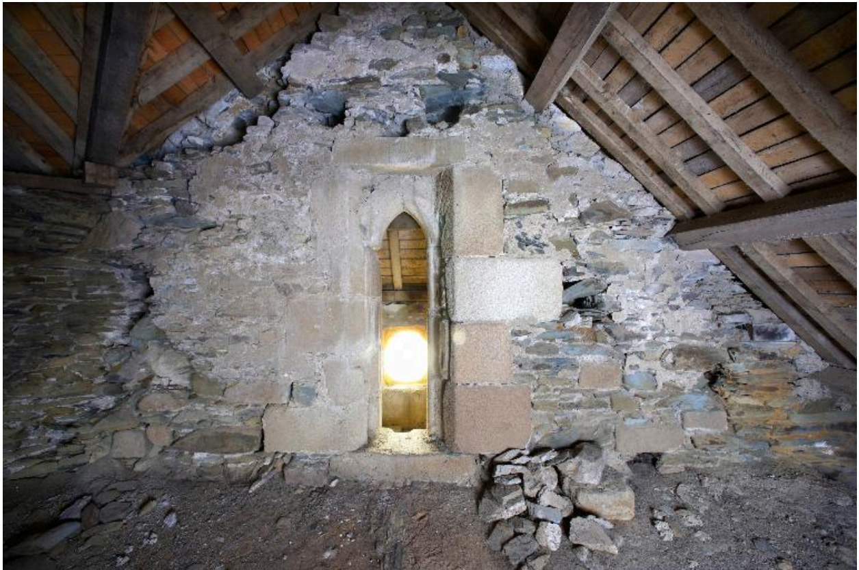
Revers du pignon de la façade occidentale depuis le comble.
