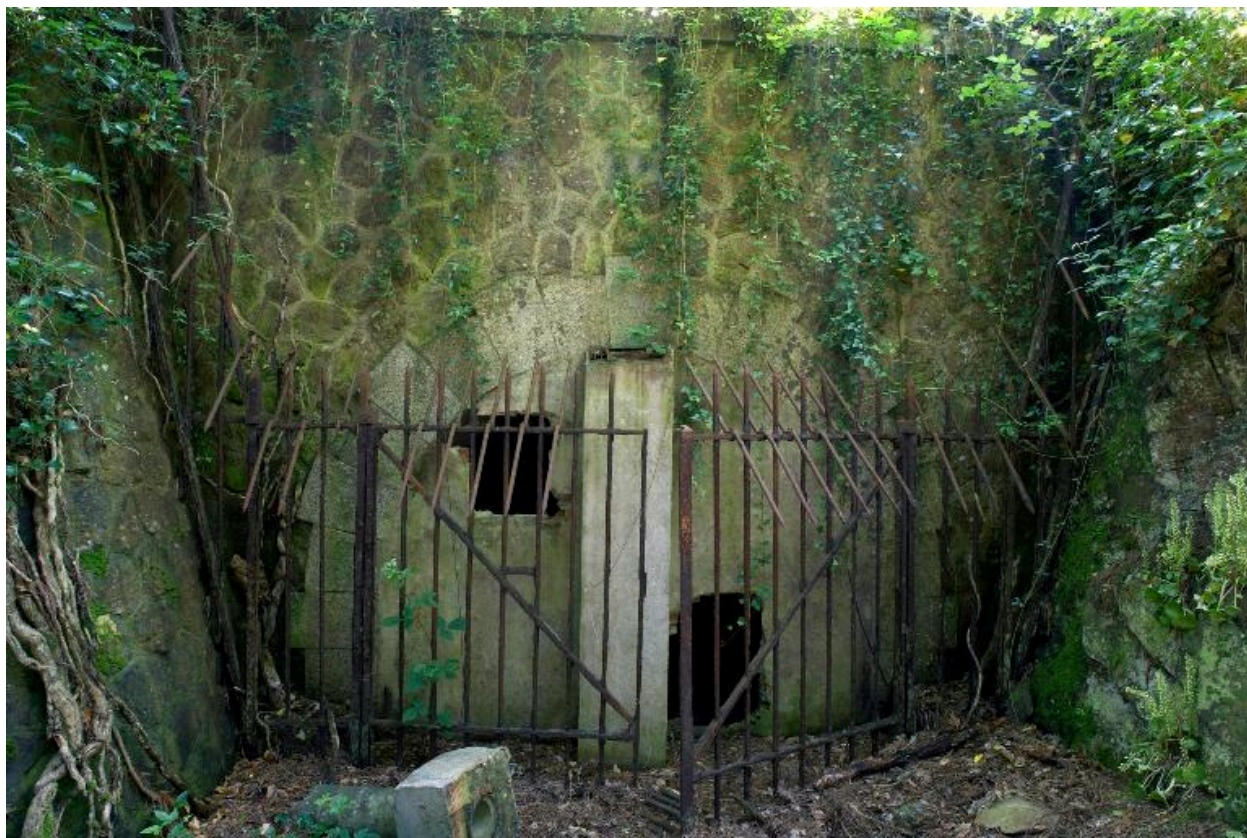
Vue du débouché du monte-charge du magasin à poudre sous roc avec ses grilles défensives
