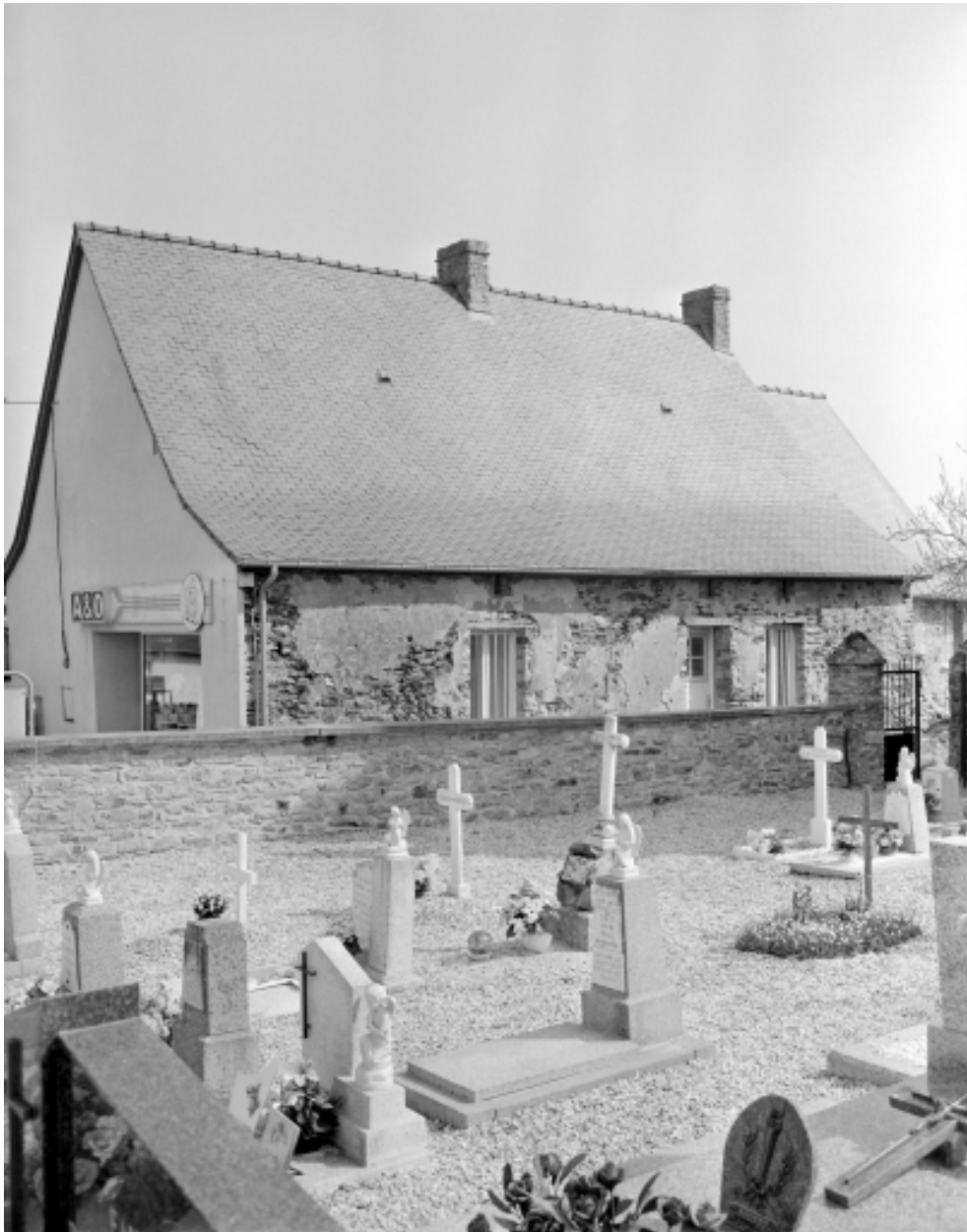
Elévation latérale : vue générale
