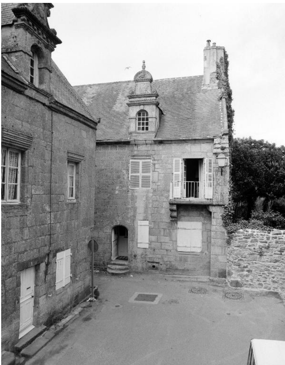
Rue des Moguerou, logis, élévation est, vue générale
