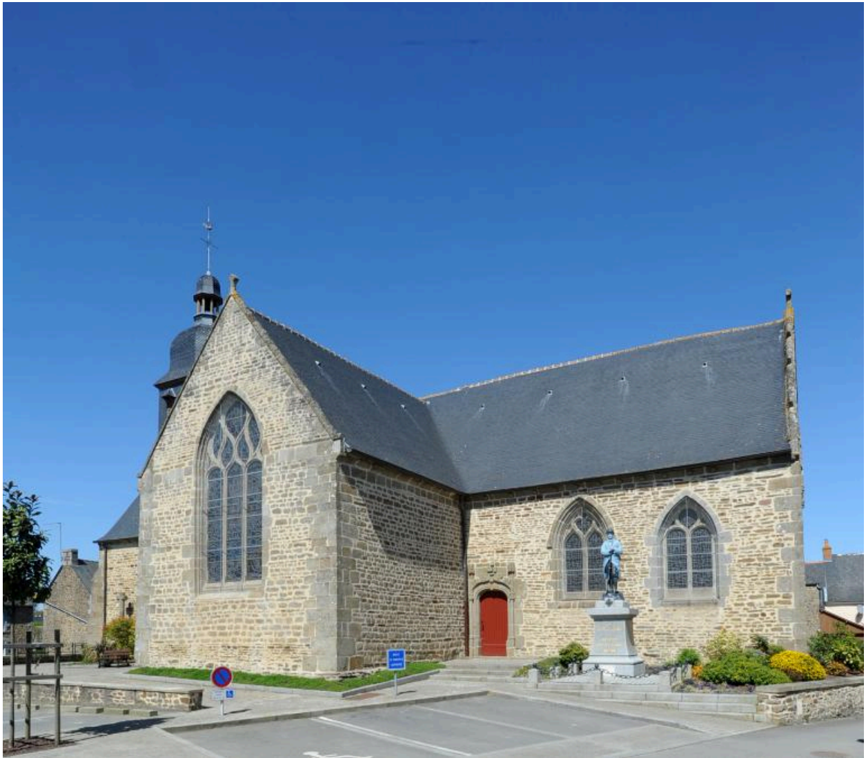
Vue générale : côté Sud-Est
