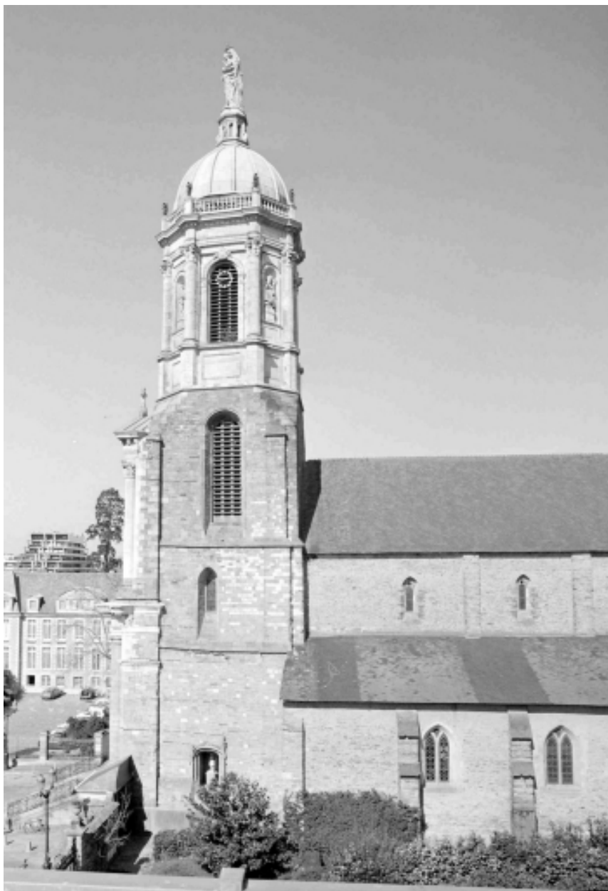
Façade sud du clocher
