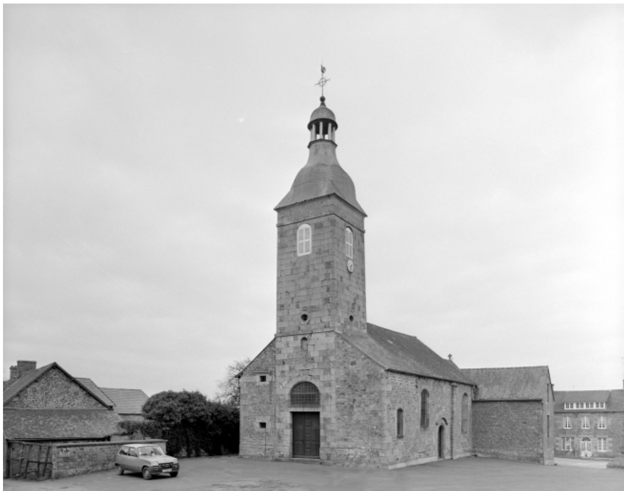
Elévation Sud-Ouest : vue générale
