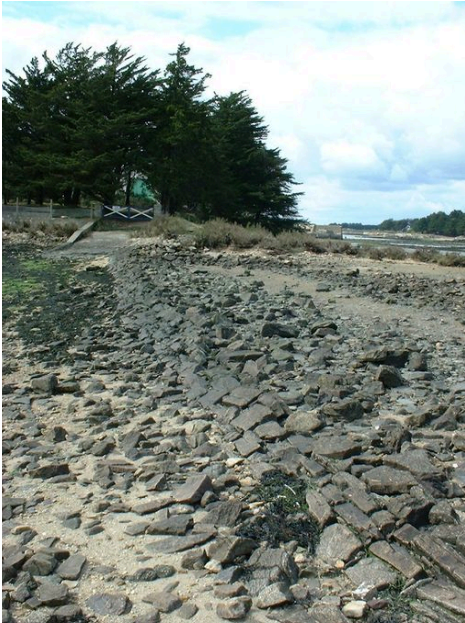
Petite digue entre l'îlot Bechit et la presqu'île de la Villeneuve
