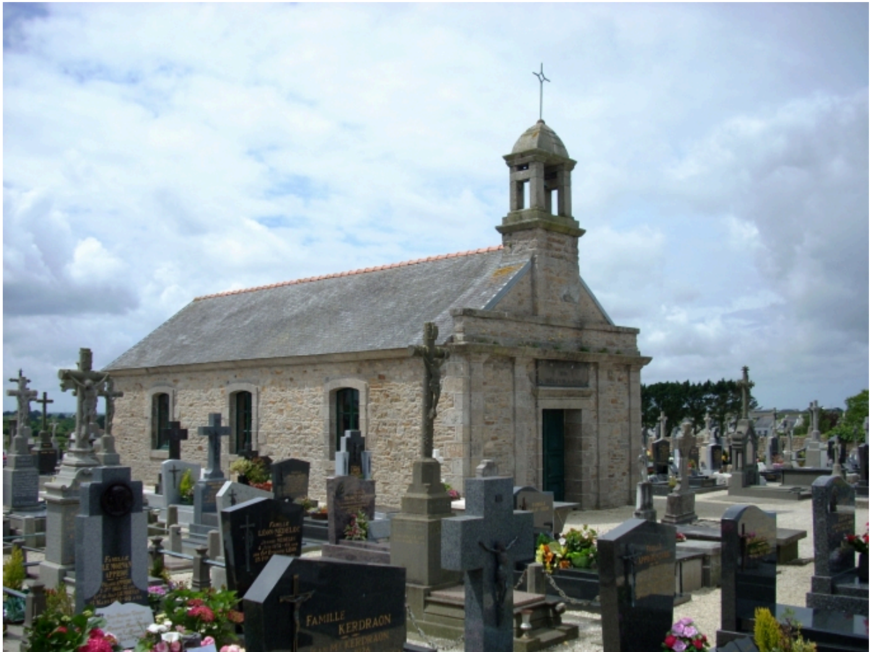
Plouguerneau, chapelle du cimetière : vue générale nord-ouest
