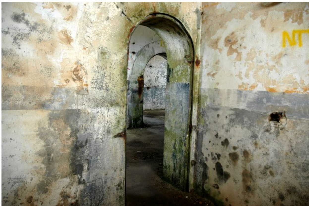
Vue du réduit de batterie de côte de Loqueltas, casernements
