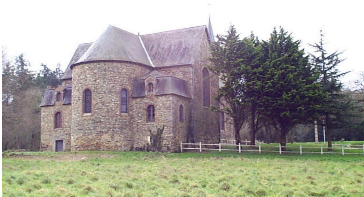
Vue de situation nord-est
