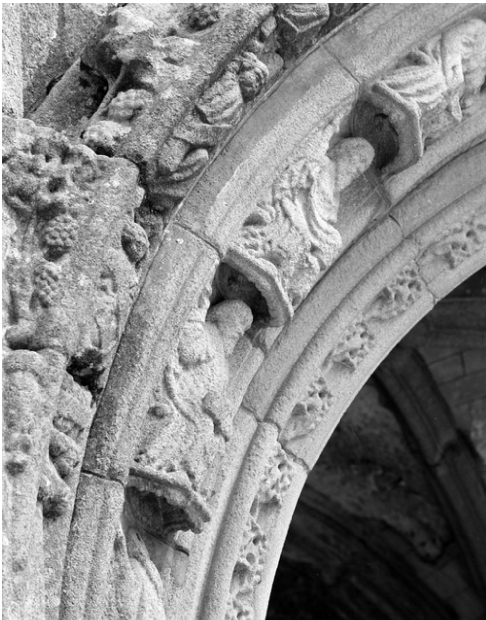
Détail porche sud
