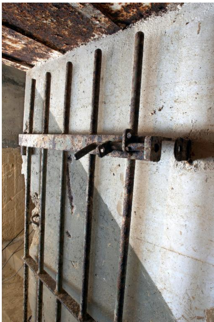
Entrée du bunker avec sa grille défensive, photographie réalisée le 11 mai 2009
