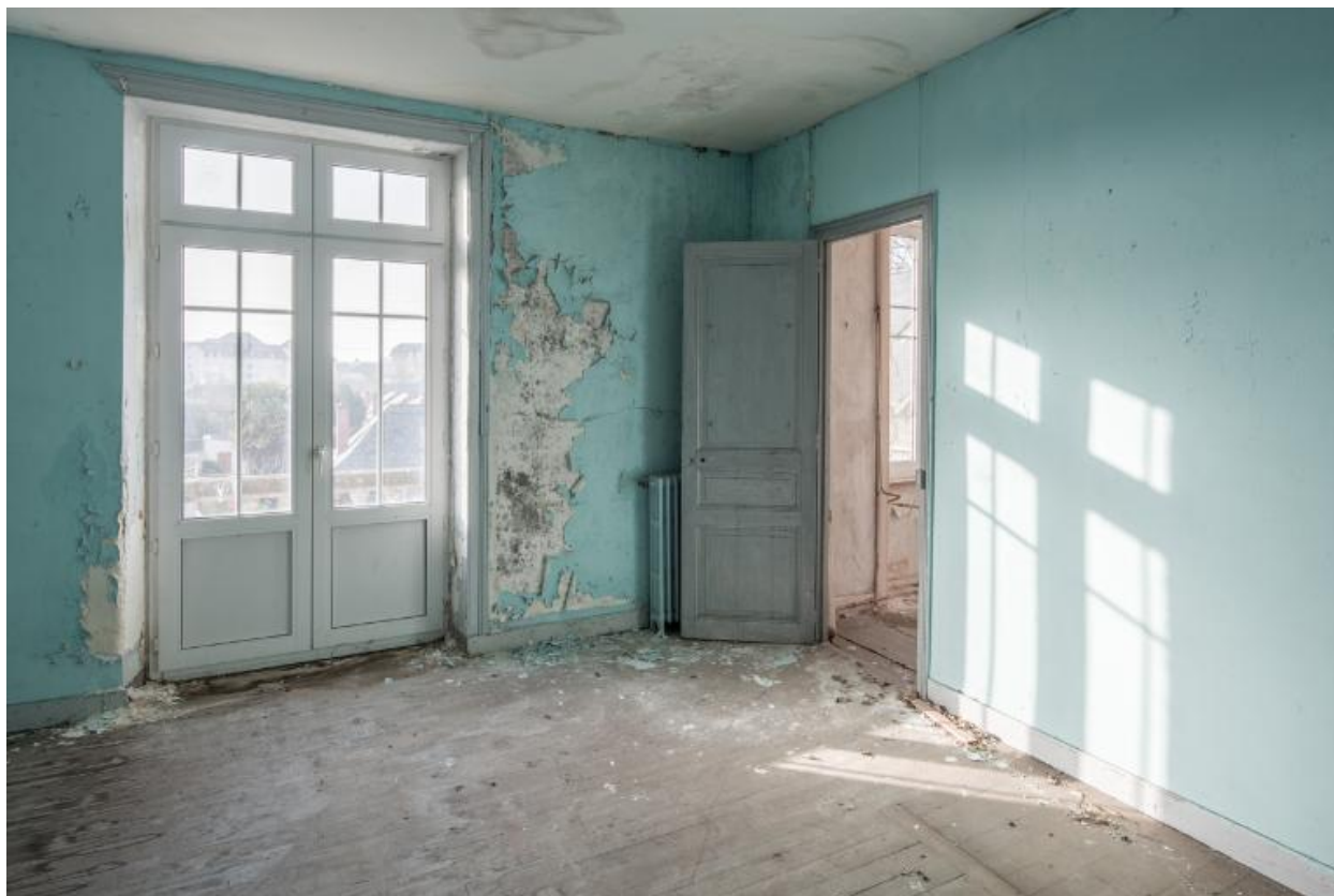
Pièce au 1er étage.
