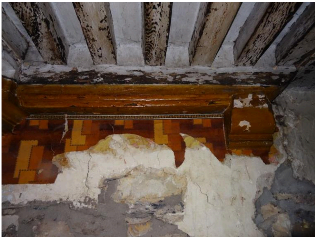
Détail de la corniche de la hotte
