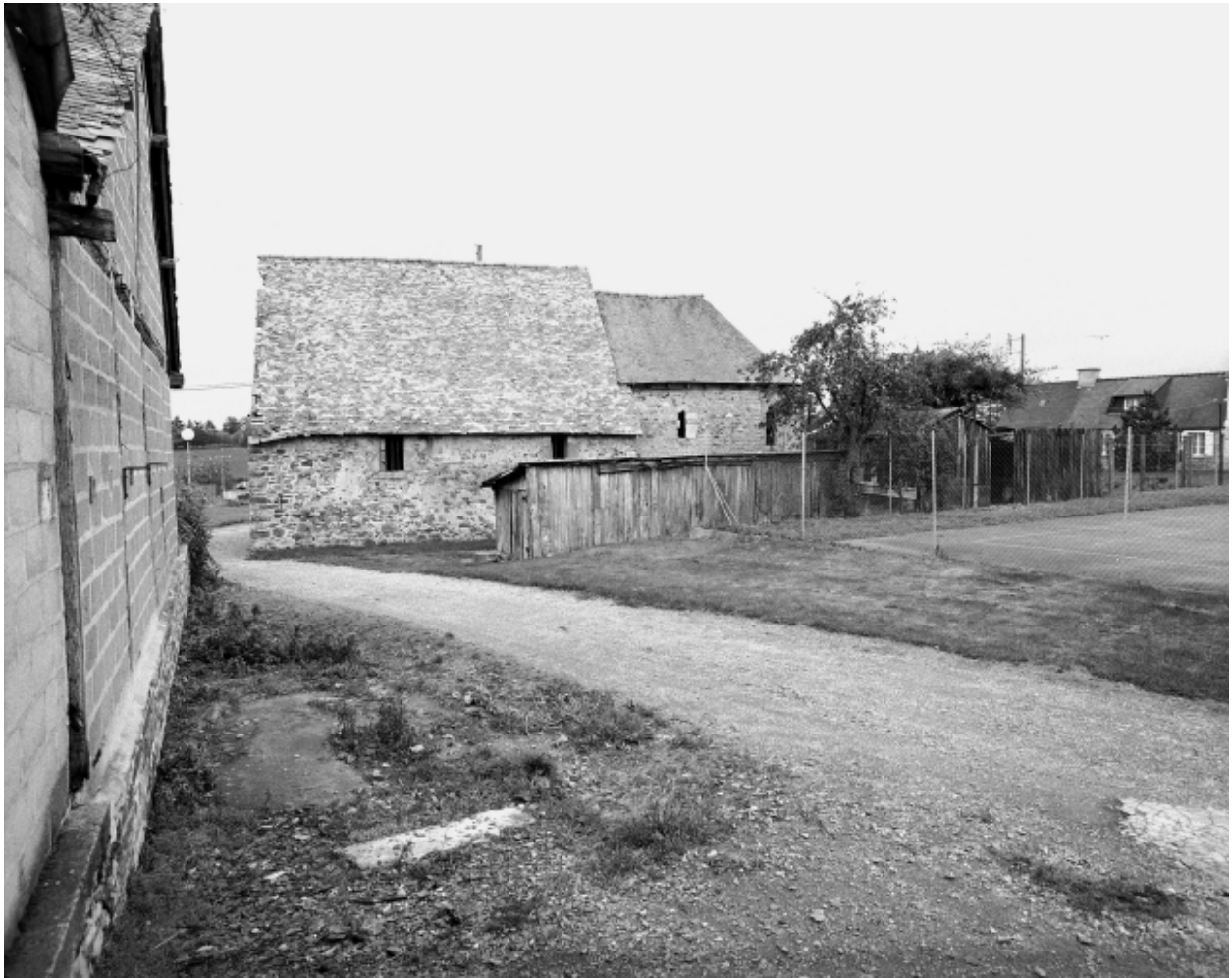
Vue de situation sud ; état en 1992
