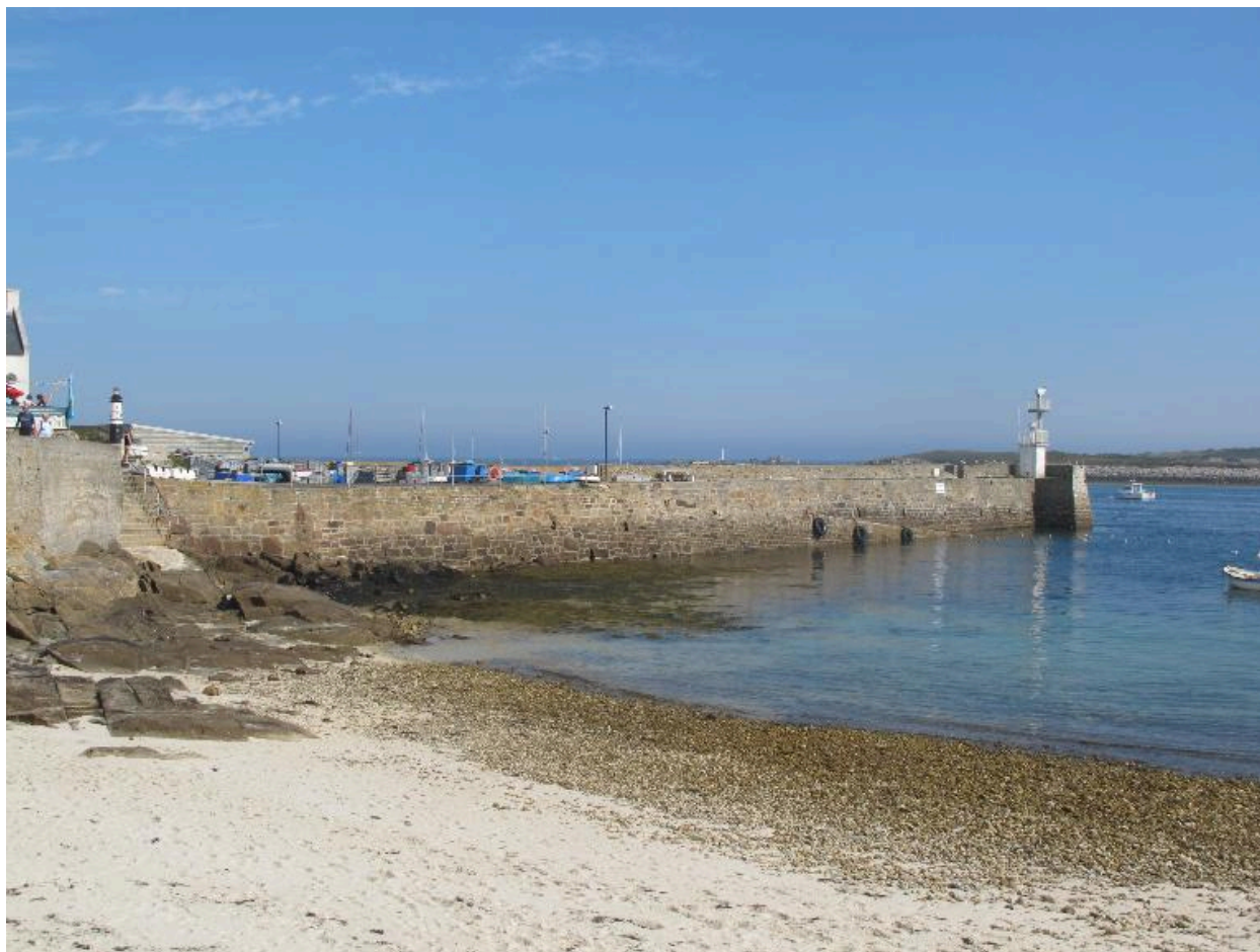
Le port de Molène, digue et cale
