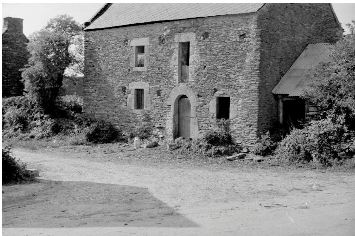
Ferme 59 (état en 1969)
