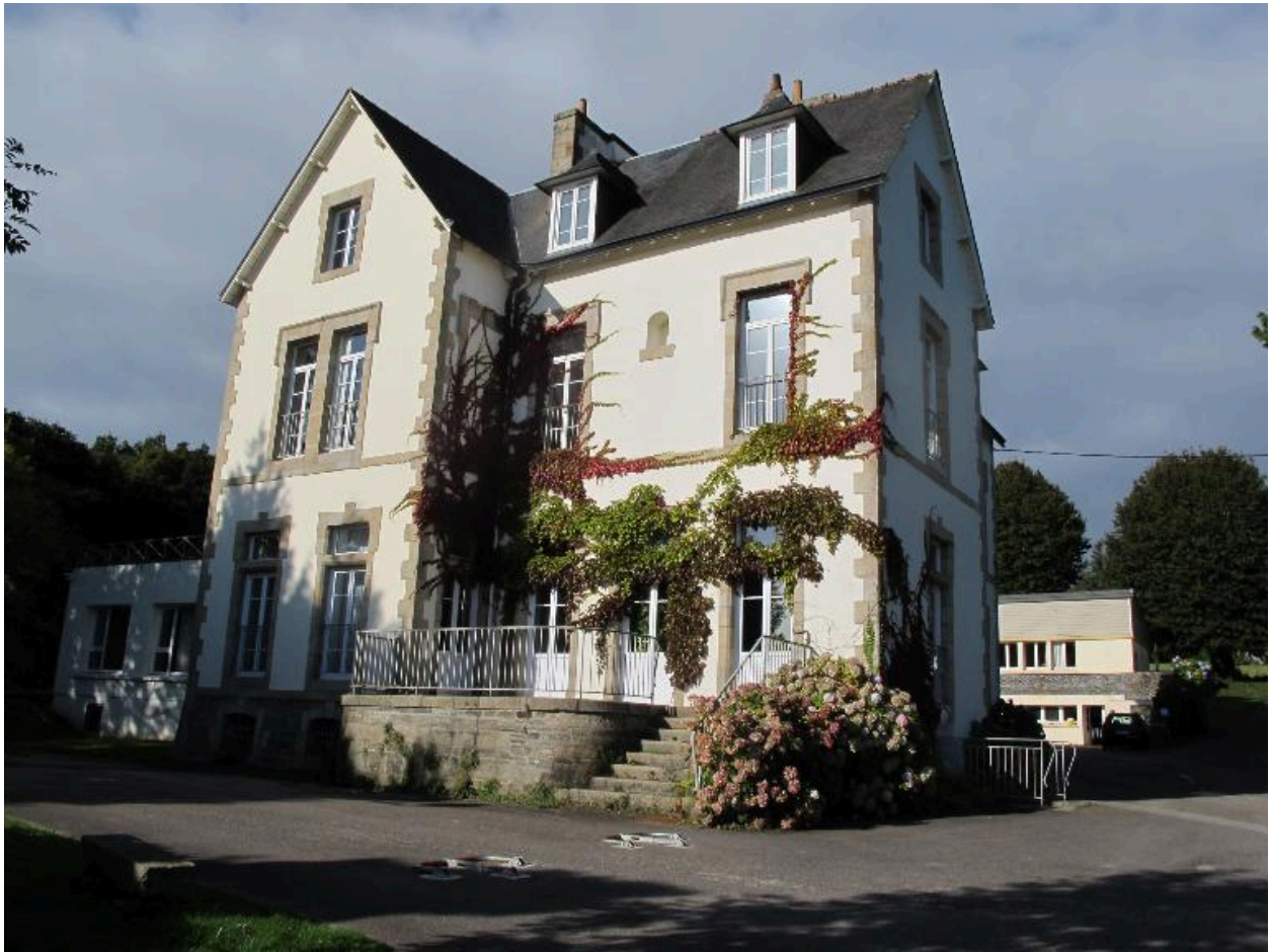
Toul ar c'hoat, façade sud
